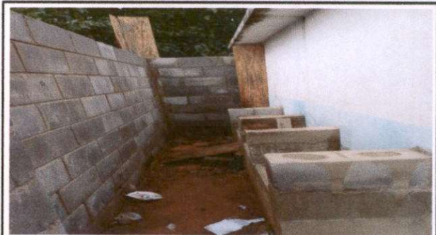
Foto 2: Sustitución de lámina por muro de block (modulo 2)
