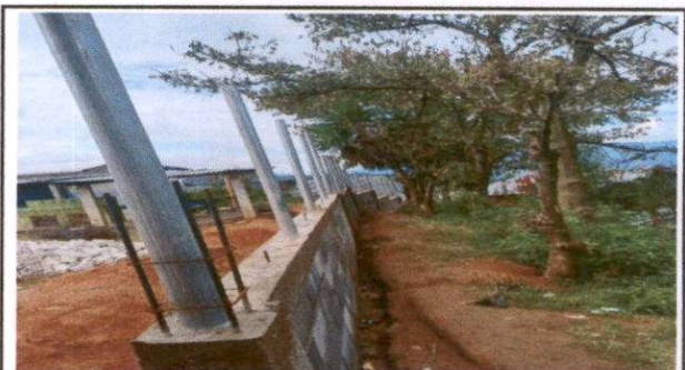
Foto 4: Sustitución de muro de malla por muro de block .
