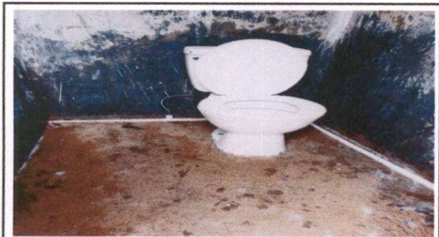
Foto 3: Sustitución de inodoro (modulo)
